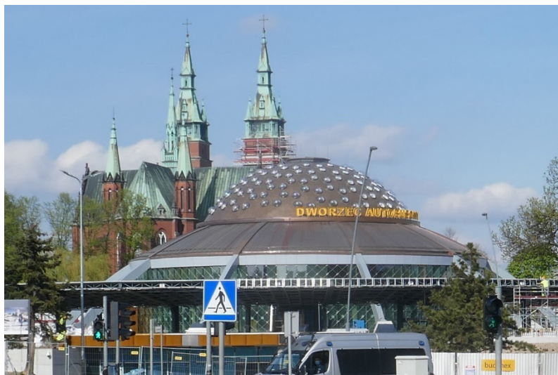
Fot. 4. Nowoczesny i pod względem formy wyjątkowy dworzec autobusowy w Kielcach
