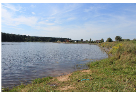
Водохранилище «Витебская ГЭС» защищаемый участок начало
