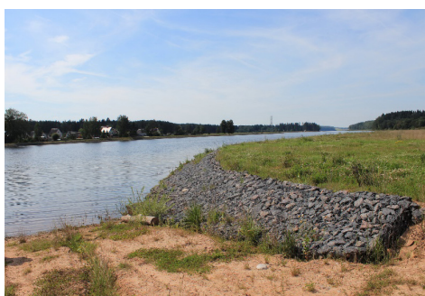
Водохранилище «Витебская ГЭС» защищаемый участок нижняя часть
