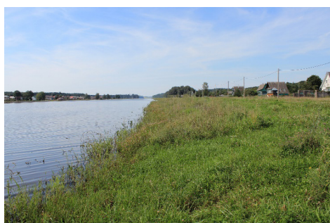
Водохранилище «Витебская ГЭС» защищаемый участок средняя часть
