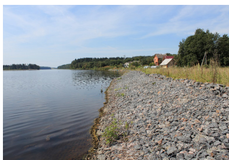
Водохранилище «Витебская ГЭС» защищаемый участок нижняя часть
